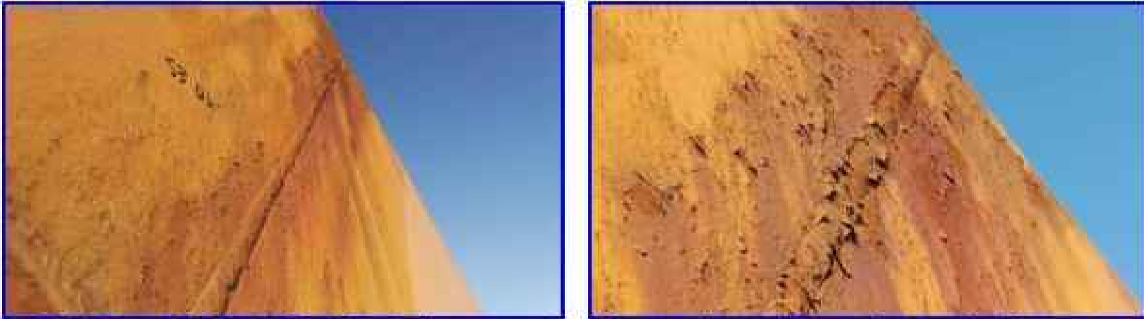
Saldatura S3 lato Dx (destro) esempio di formazione di ruggine e sfogliamento vernice.
